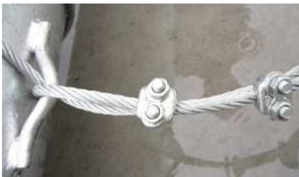
Рис. 3.7 Крепление железных тросов
